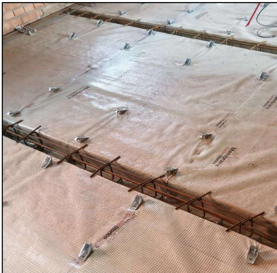
Consolidamento solaio in legno a doppia orditura su trave principale.
