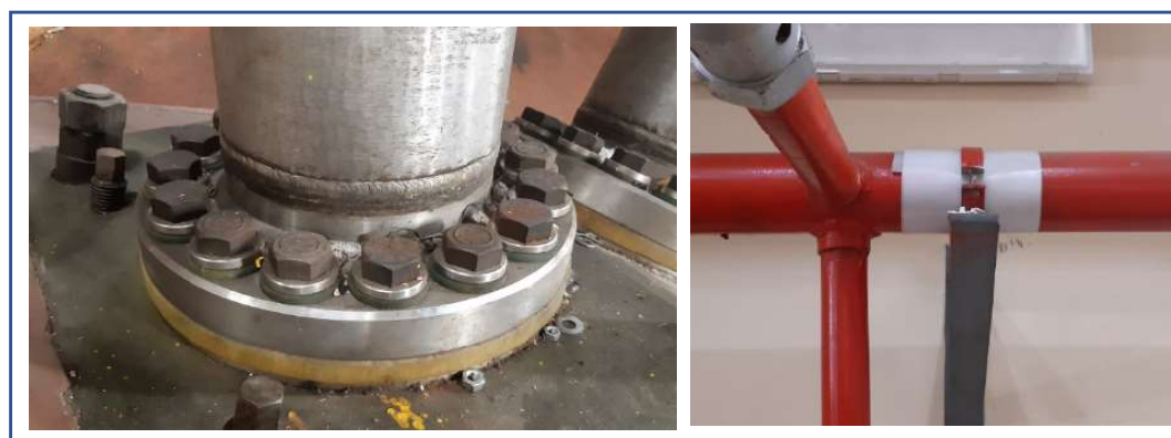
Isolamento delle masse nella tourus hall ecc...
