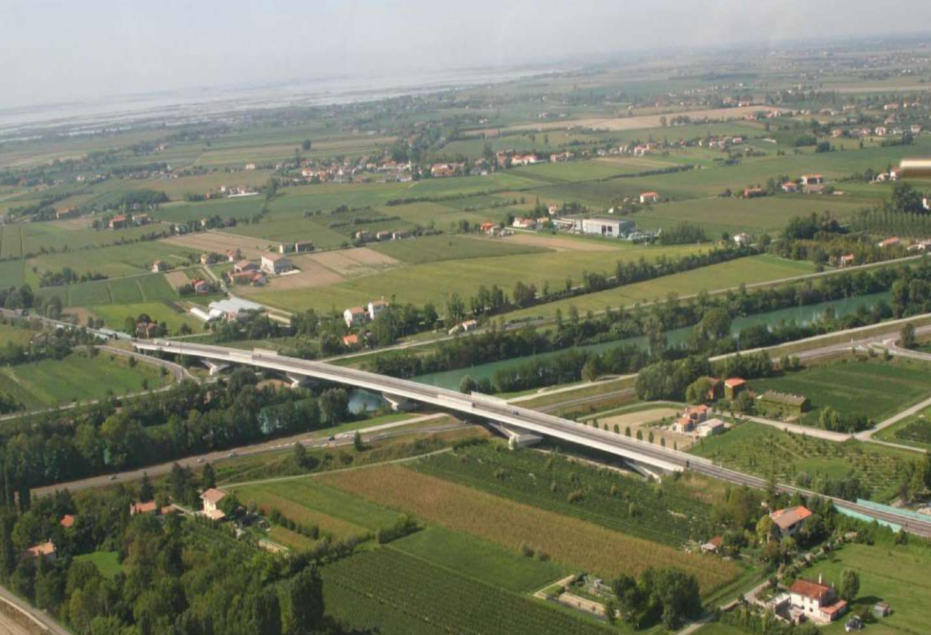
E. Siviero, The San Donà Bridge - Venice
