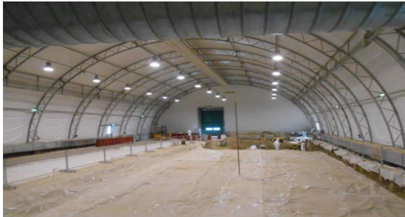
Capannone trincee 2 e 3
