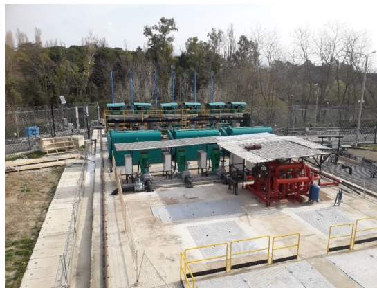
Ripristino Opera di Presa
