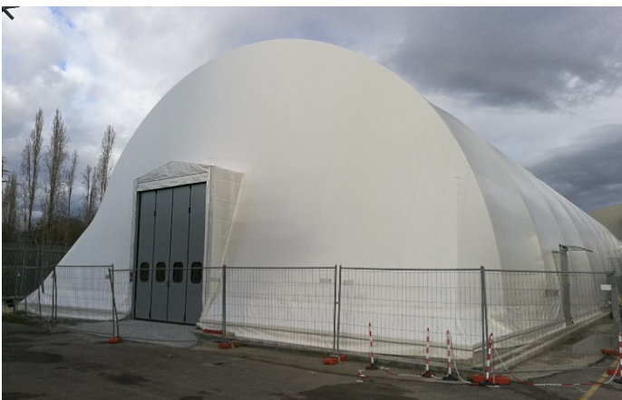
Struttura di confinamento Trincea n. 1
