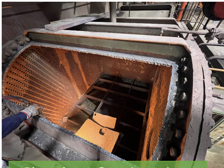
Rimozione Condensatore
