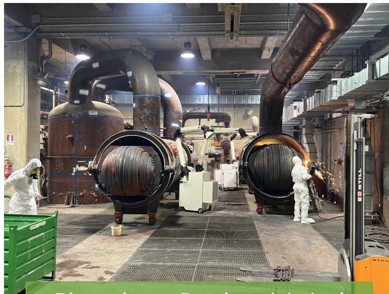
Rimozione Preriscaldatori
