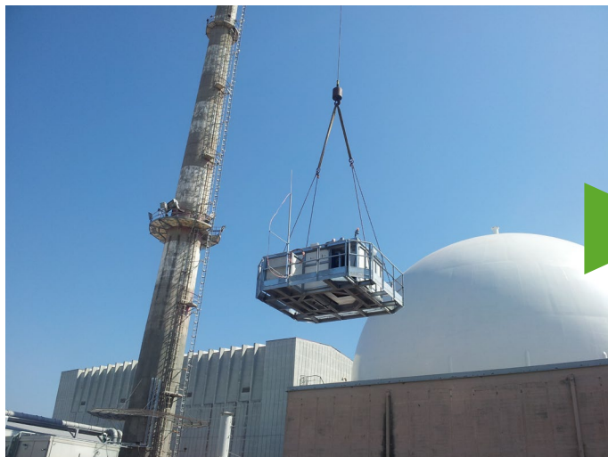
Il vecchio camino in fase di demolizione
