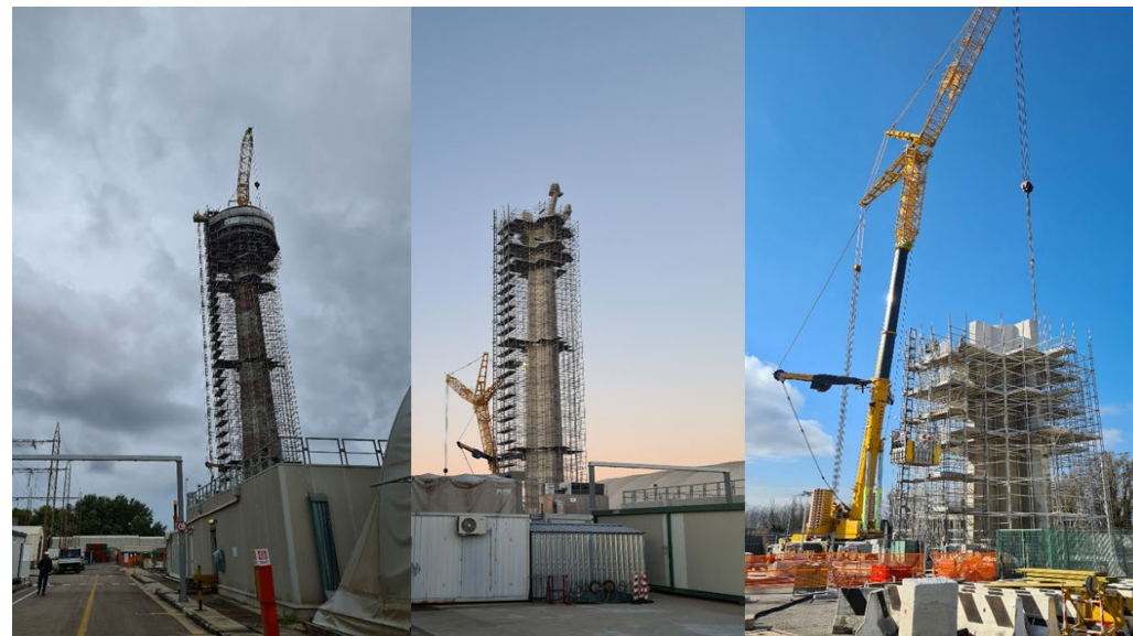
Sequenza smantellamento torre idrica
