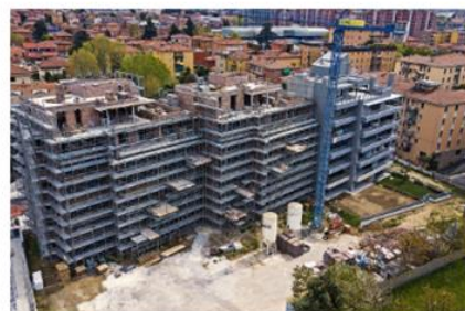
Palazzine 7 piani Esempio edificio Classe SB
