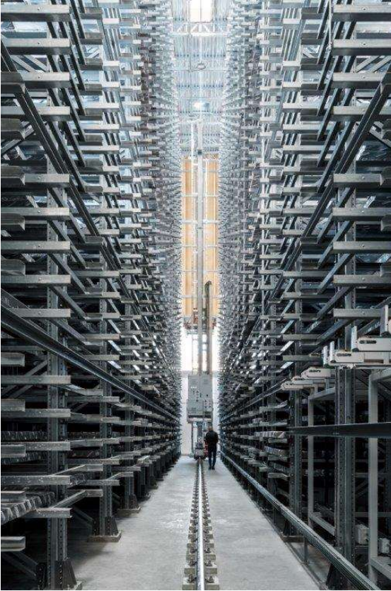
Magazzino autoportante automatizzato
