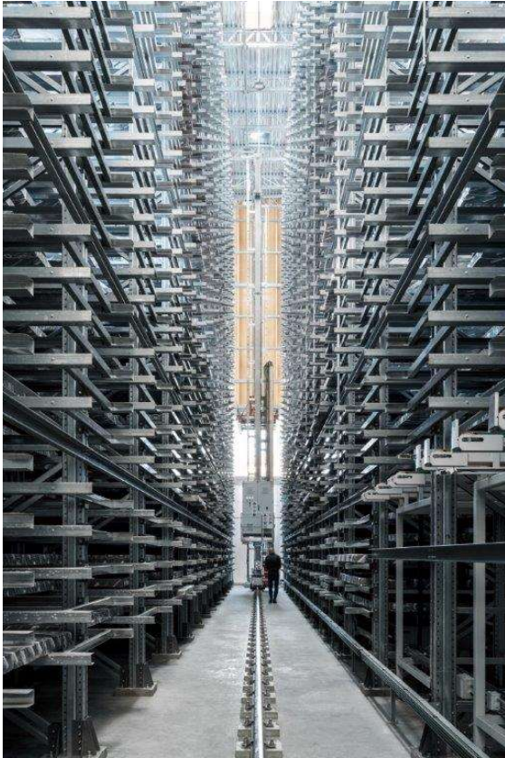
Magazzino autoportante automatizzato
