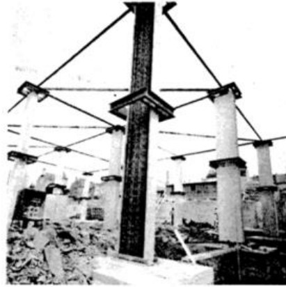
Fig. 10. — Colonne mixte AF 120 reprenant des charges jusque 8000 kN et supportant directement des planchers massifs en béton.
