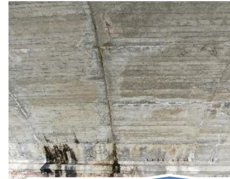
Intradosso di campata
