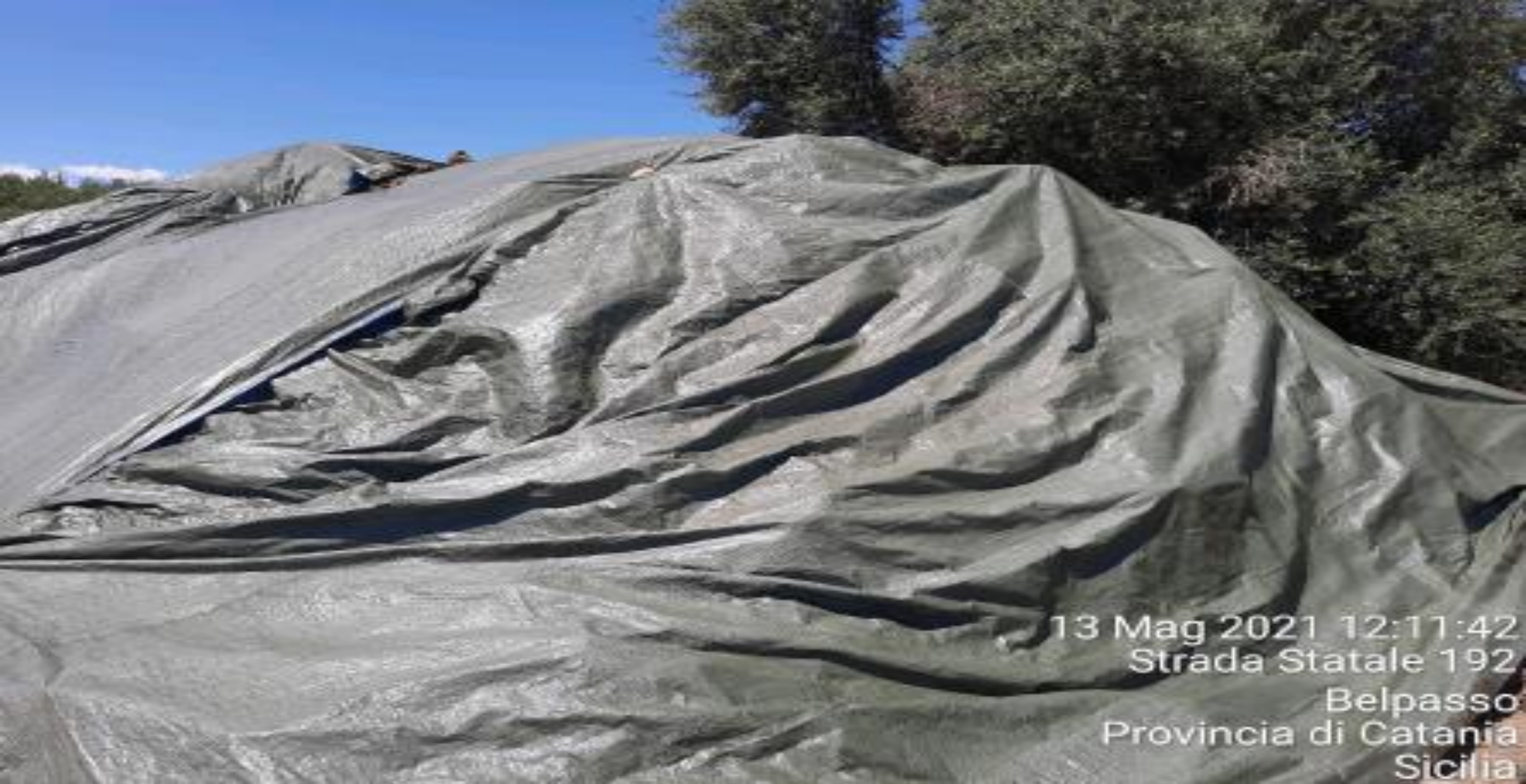
Deposito di terre e rocce da scavo coperto
