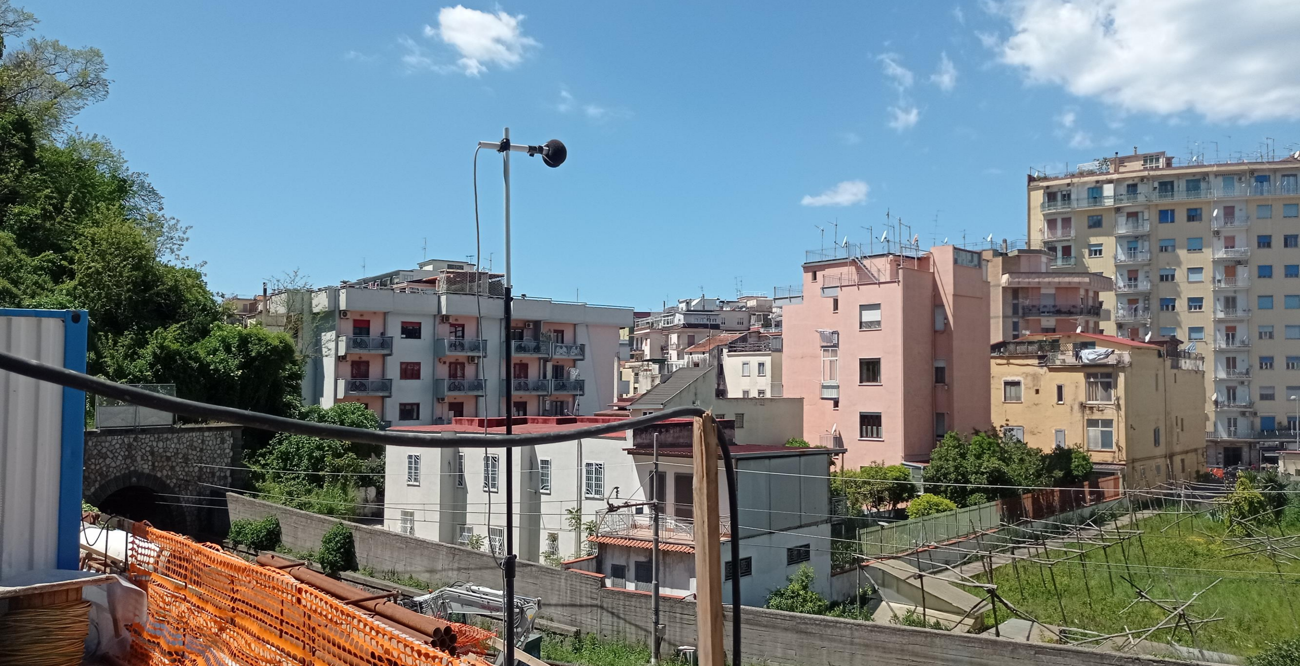
Cantiere Circumvesuviana «Castellamare di Stabia»
