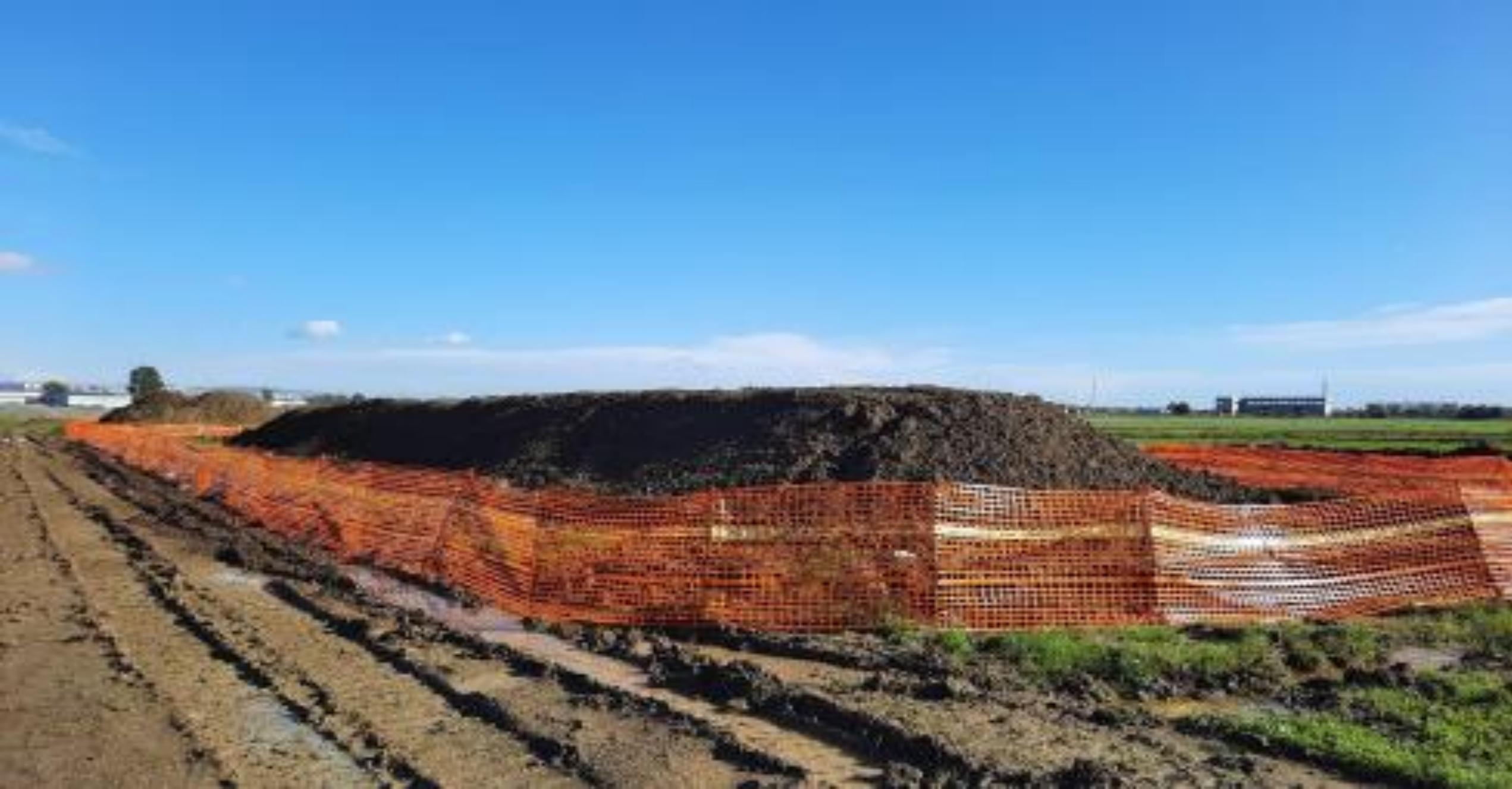
Deposito temporaneo di terre e rocce da scavo in attesa di riutilizzo
