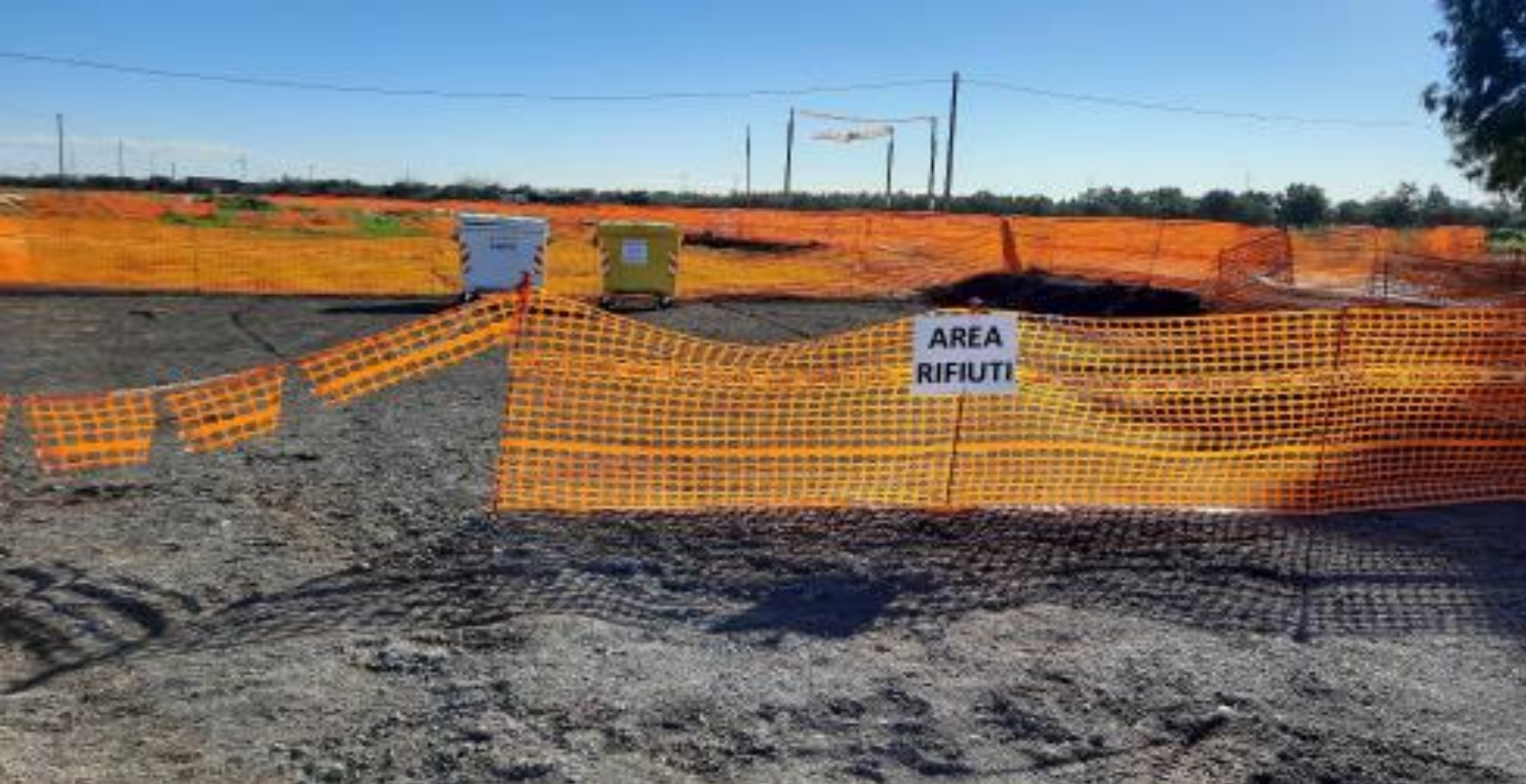
L'area del cantiere destinata al deposito temporaneo dei rifiuti è correttamente delimitata e identificata mediante cartellonistica
