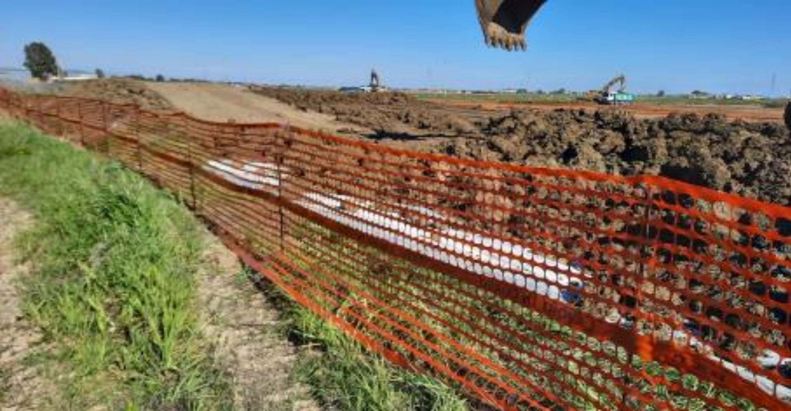
Allestimento cumulo di terre e rocce da scavo in attesa di riutilizzo
