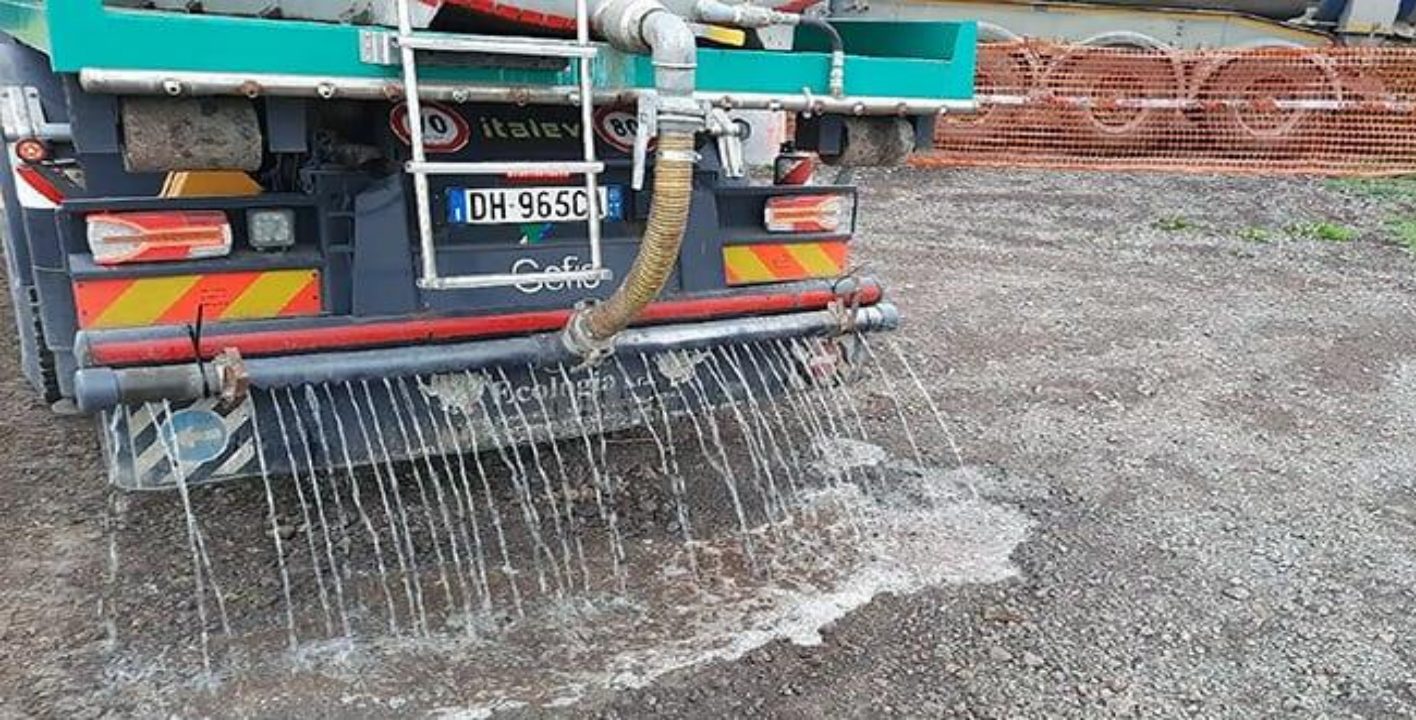
Bagnatura pista di cantiere
