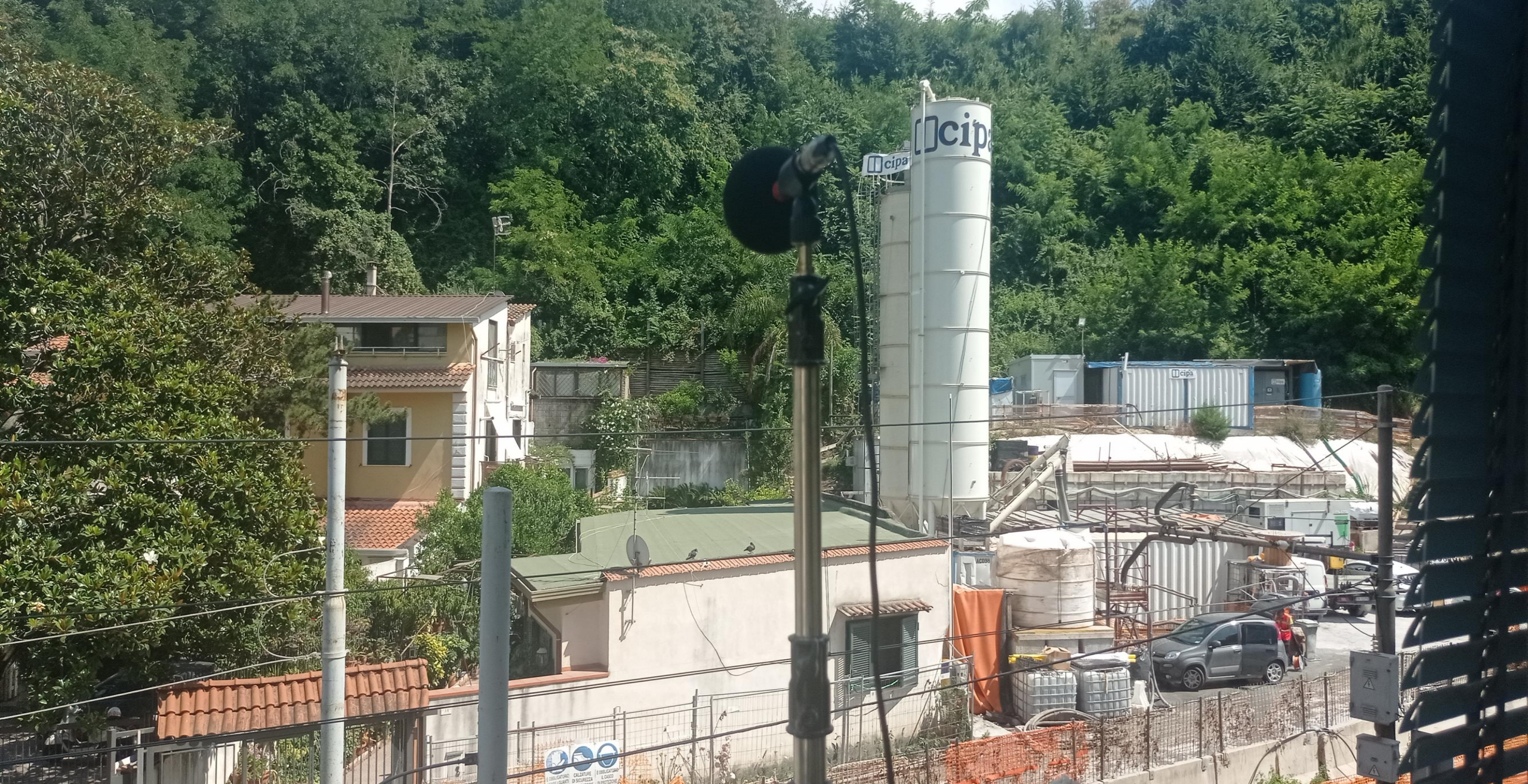
Cantiere Circumvesuviana «Castellamare di Stabia»
