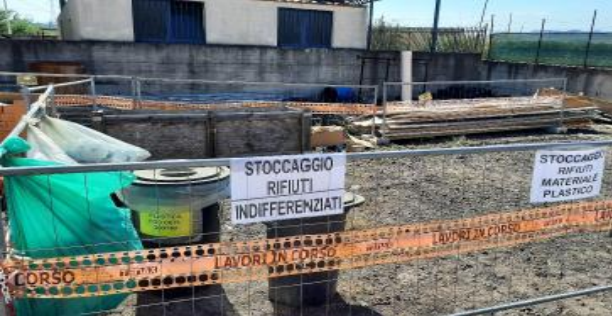
Area adibita a deposito temporaneo dei rifiuti nel cantiere base
