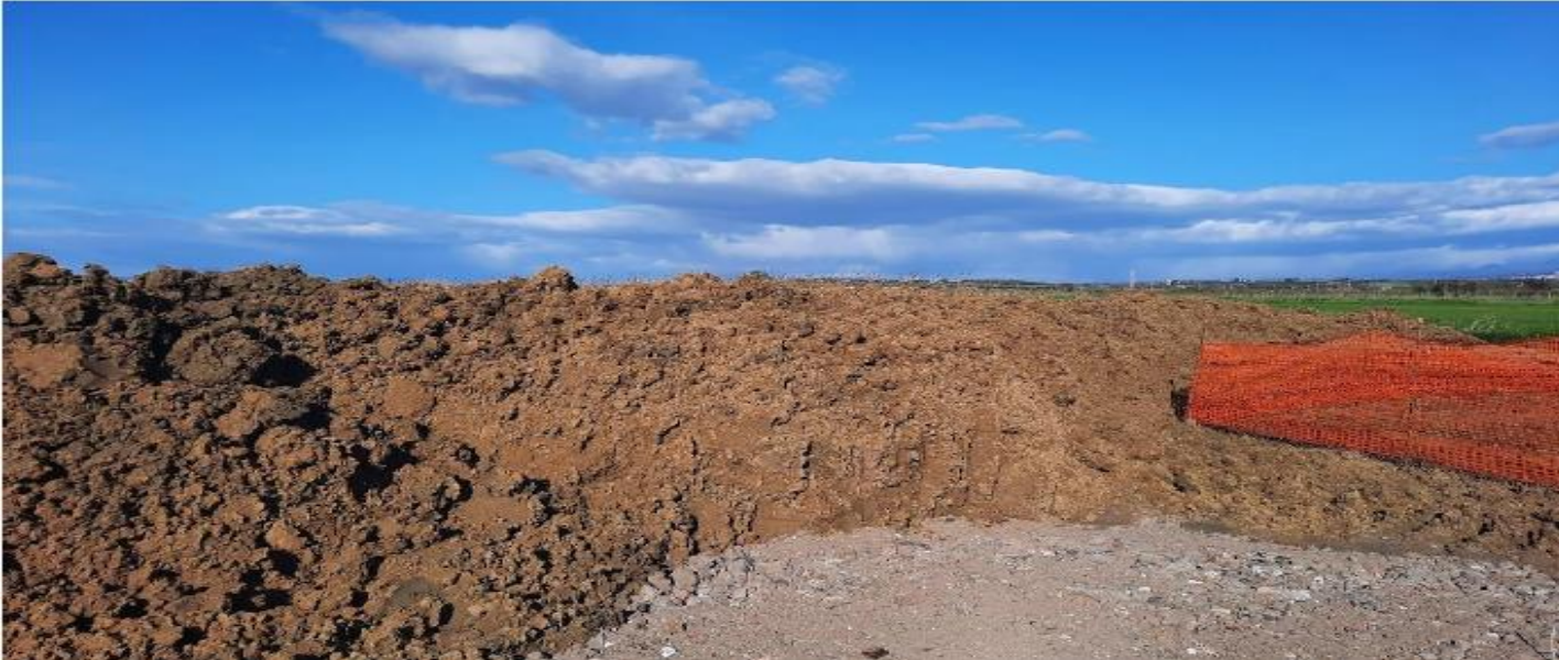
Cumulo di terre e rocce da scavo ubicato nel microcantiere
