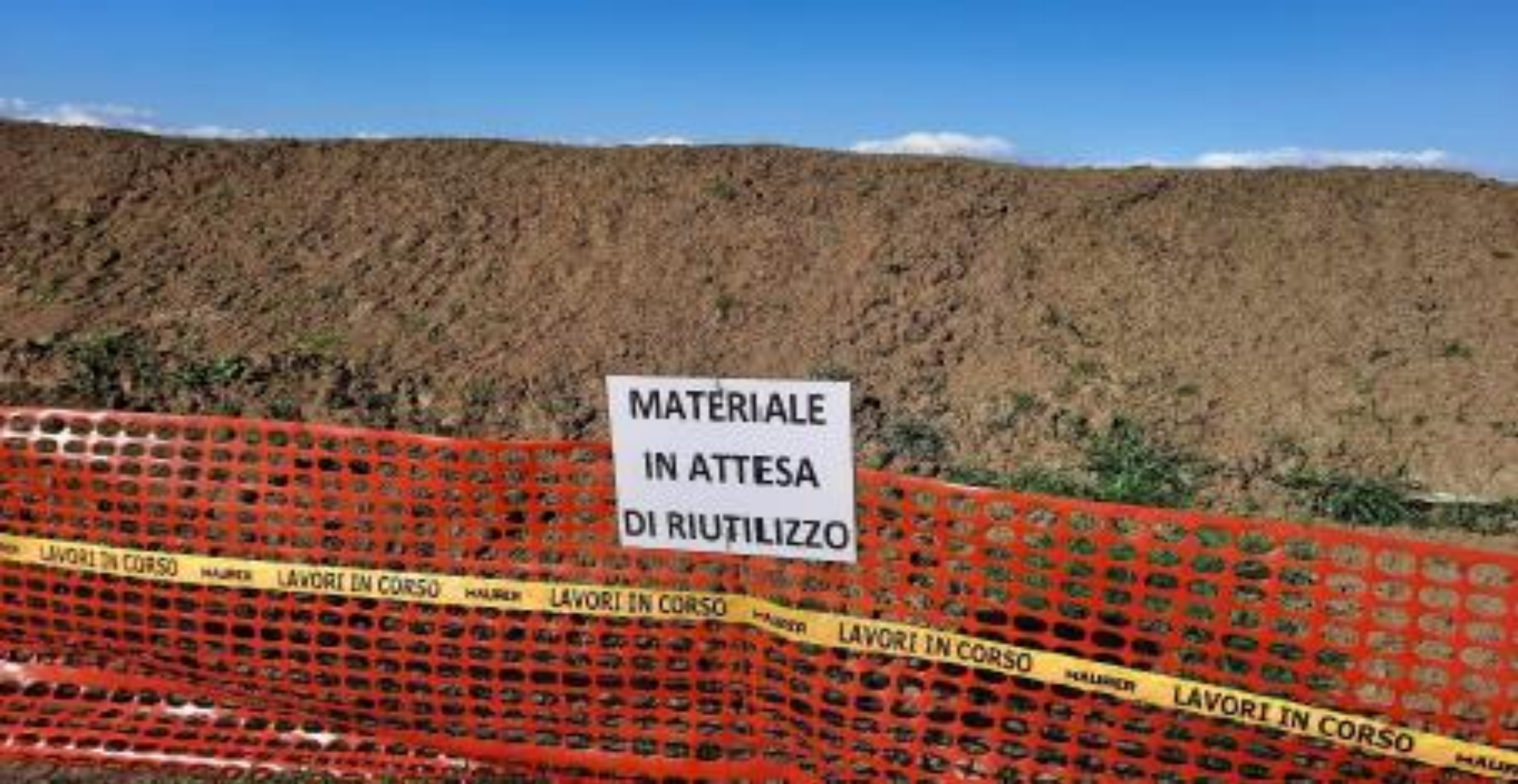
Identificazione di una delle aree di deposito delle terre e rocce da scavo in attesa di riutilizzo
