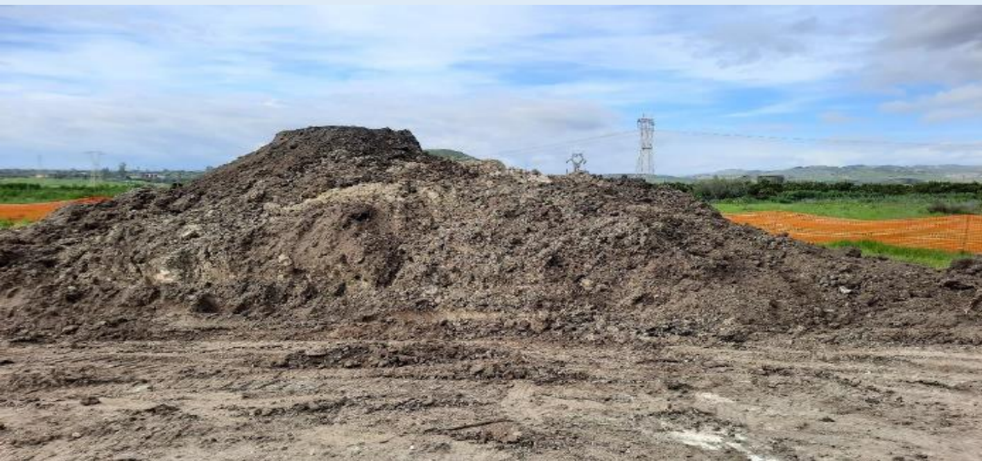
Cumulo di terre e rocce da scavo ubicato nel microcantiere
