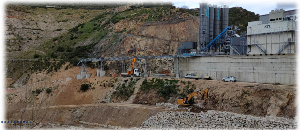
Impianto di betonaggio di cantiere. ....
