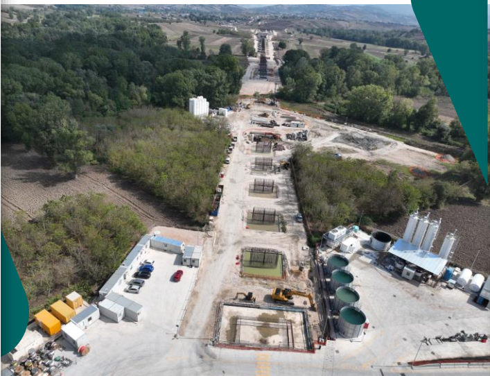
VI01 – Viadotto Hirpinia
