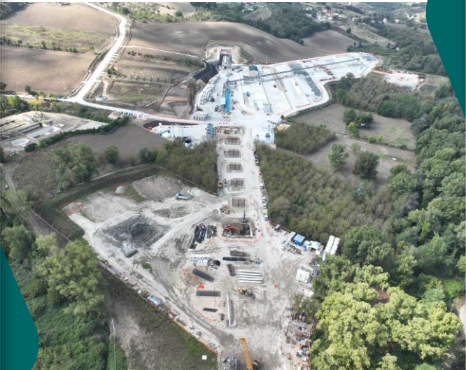
GN01 – Galleria Grottaminarda VI01 – Viadotto Hirpinia
