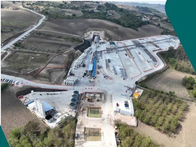
GN01 – Galleria Grottaminarda VI01 – Viadotto Hirpinia
