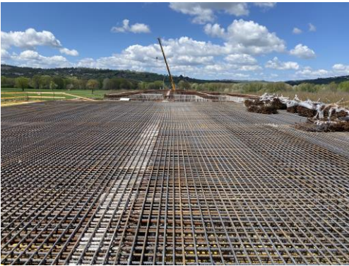
RI01 – Rilevato su scatolare
