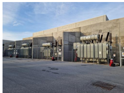
Trasformatori AT/MT 150/20kV
