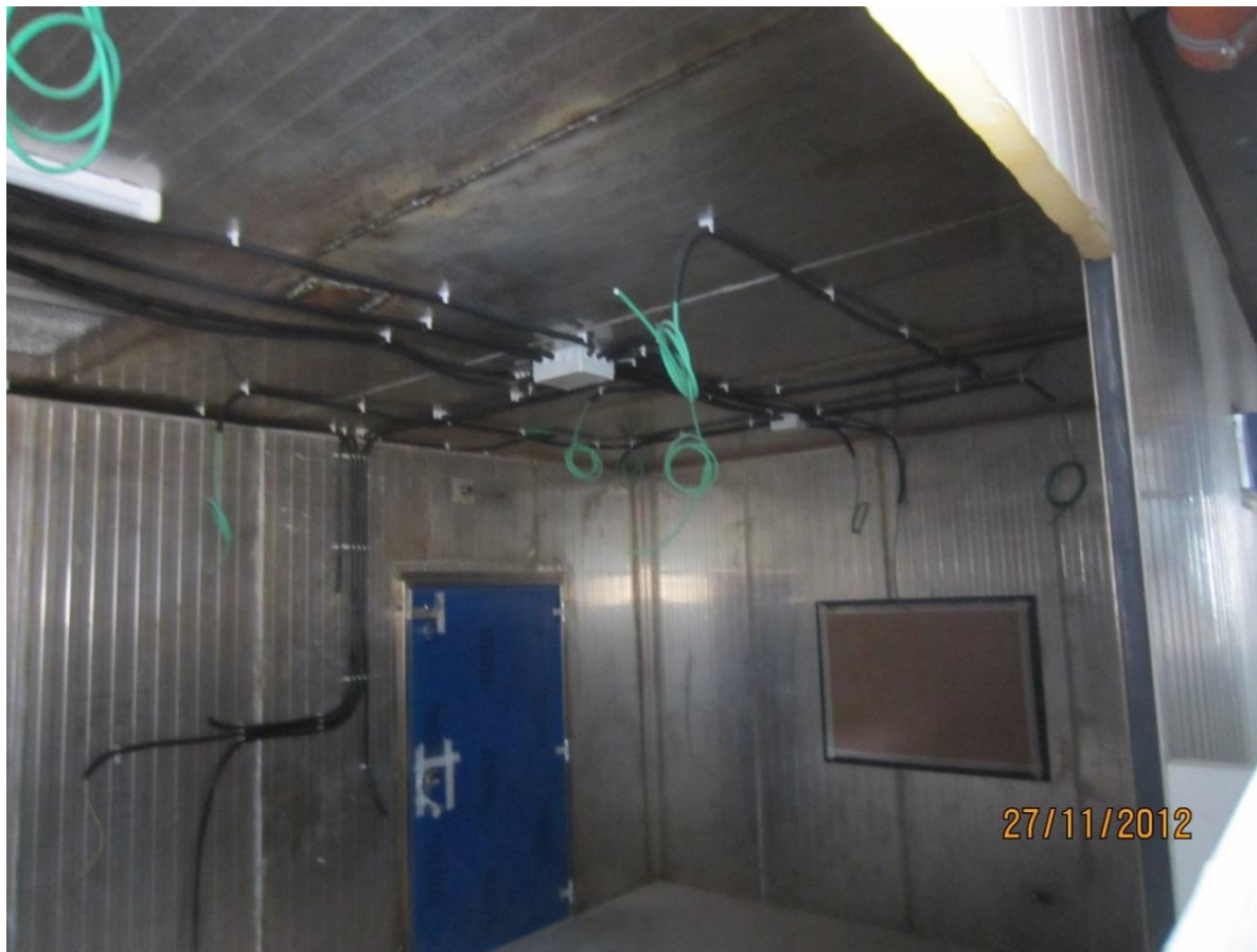
Cabina in Pannelli sandwich con foglio interno in alluminio
