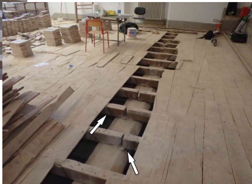
Rimozione parziale del solaio
