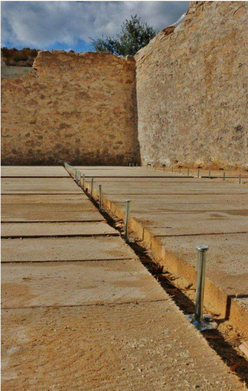
Connettore BASE su assito interrotto
