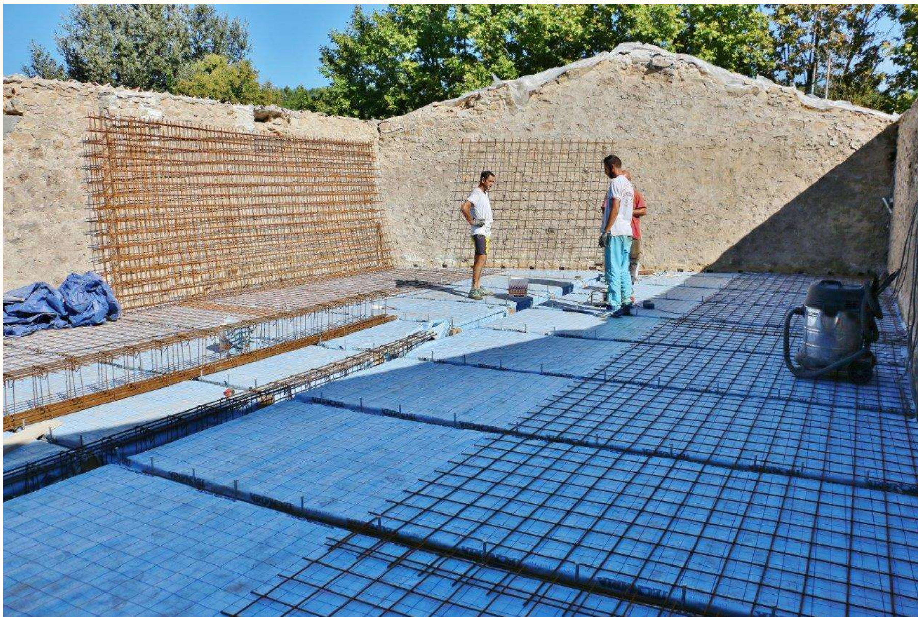
Connettore BASE su assito interrotto
