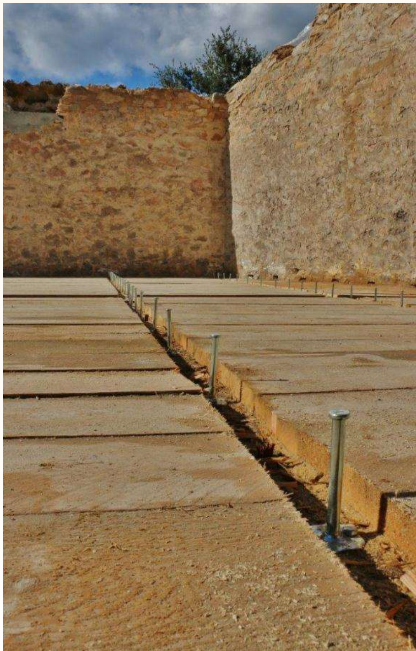
Connettore BASE su assito interrotto
