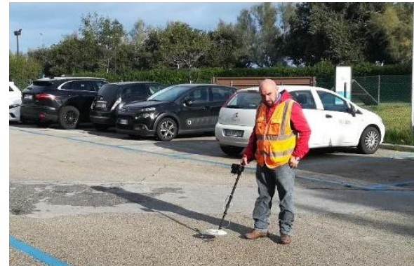
Ricerca pozzetti sepolti con cerca-chiusini
