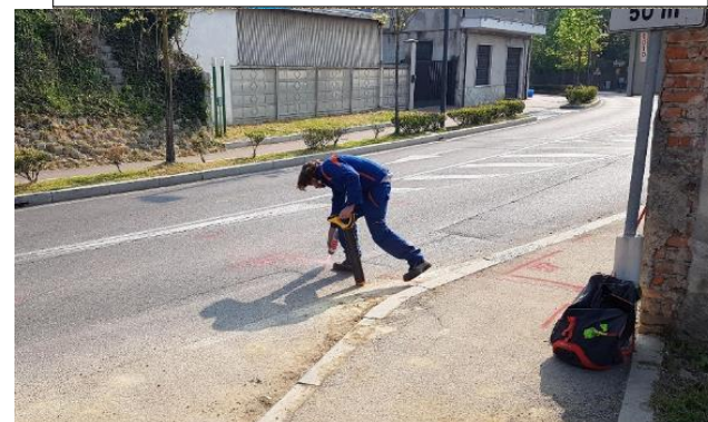
Tracciamento reti da parte degli enti gestori
