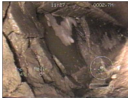
Foto: 2, Video: VHS 1, : : Particolare lesione che interessa la platea e le pareti
