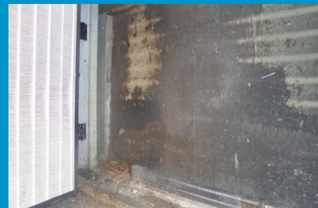
Batteria sporca e intasata
