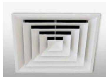
**Pulizia** ed igienizzazione dei terminali mediante asportazione dei residui di polveri, morchia, materiale untuoso e qualsiasi altro materiale depositato sulle superfici, mediante l'utilizzo di soluzione ad elevato potere disincrostante;
