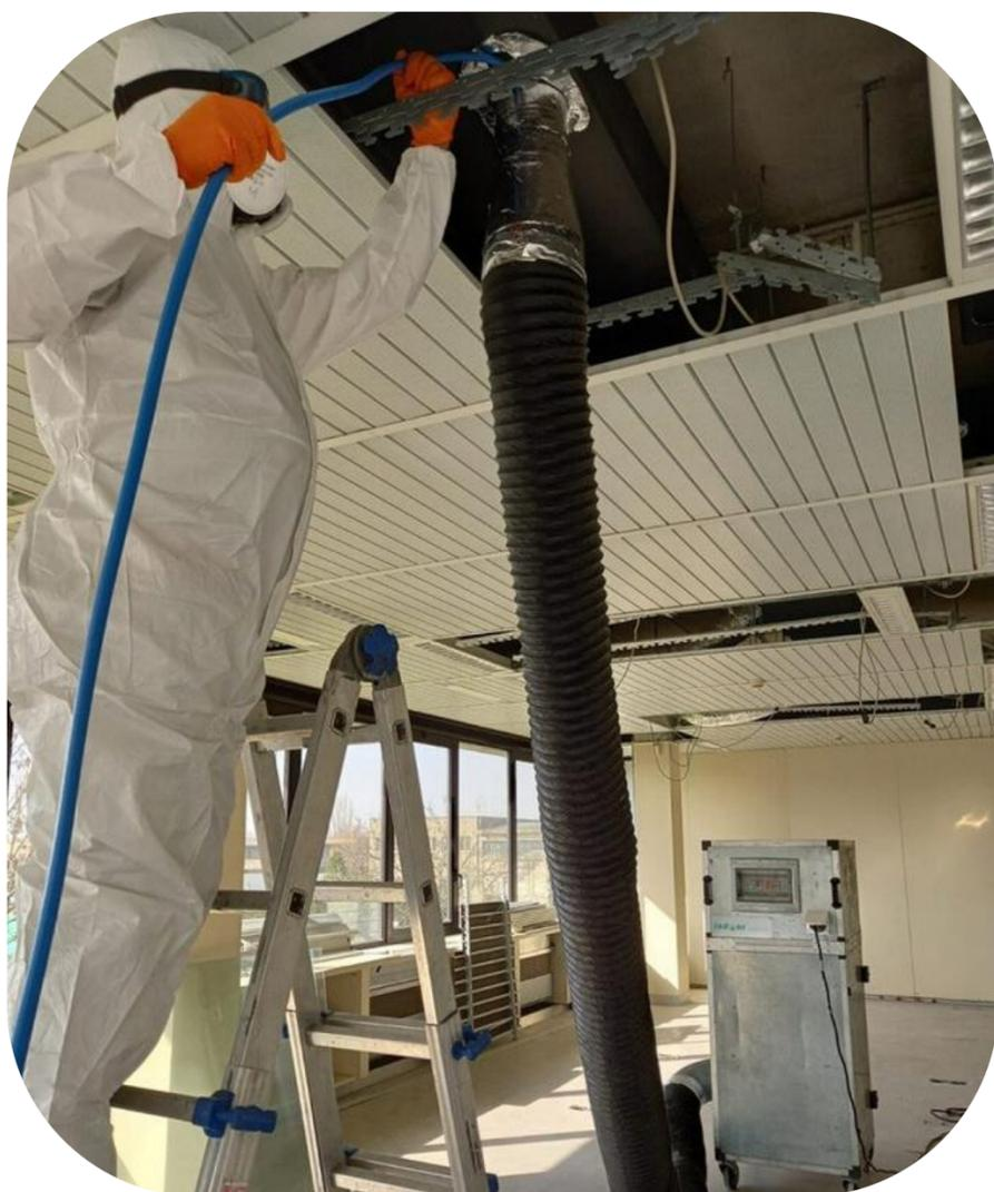
Pulizia di tutte le canalizzazioni mediante asporto del particolato polveroso e detriti presenti all'interno delle stesse a mezzo di testine pneumatiche alimentate ad aria compressa facenti parte della tecnologia brevettata *Collom*. L'azione combinata della pressione positiva della sonda *Collom* e la pressione negativa dell'aspiratore **ULPA** creano un effetto ciclonico che assicura il distacco e il convogliamento e verso l'aspiratore di tutti i contaminanti interni alle condotte.
