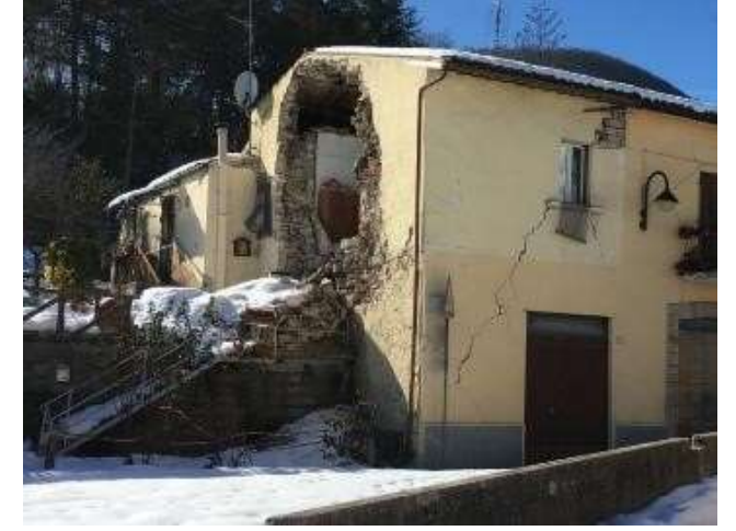
2016 – Edificio privato, San Severino
