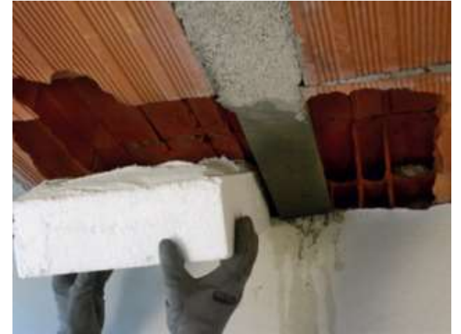
Riempimento pignatta con EPS incollato e rasato con Keraklima Eco Granello
