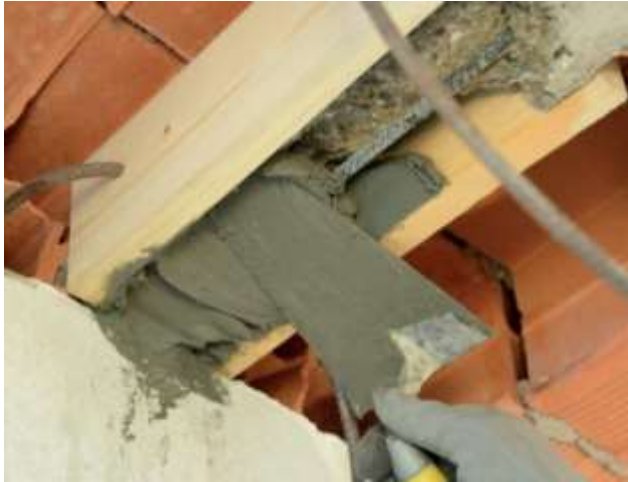
Ricostruzione travetto con Geolite
