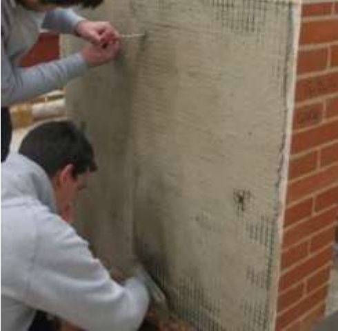
Realizzazione provini a scala reale
