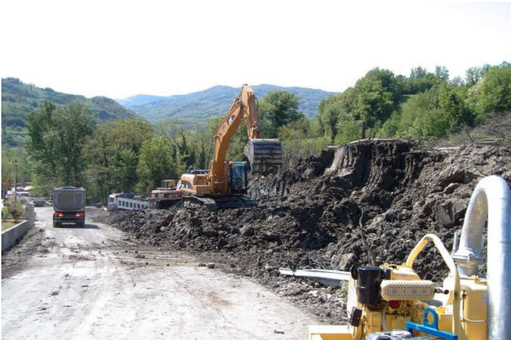
PIEDE COLATA – RIMOZIONE TERRENO IN AVANZAMENTO SUL FRONTE – APRILE MAGGIO 2004
