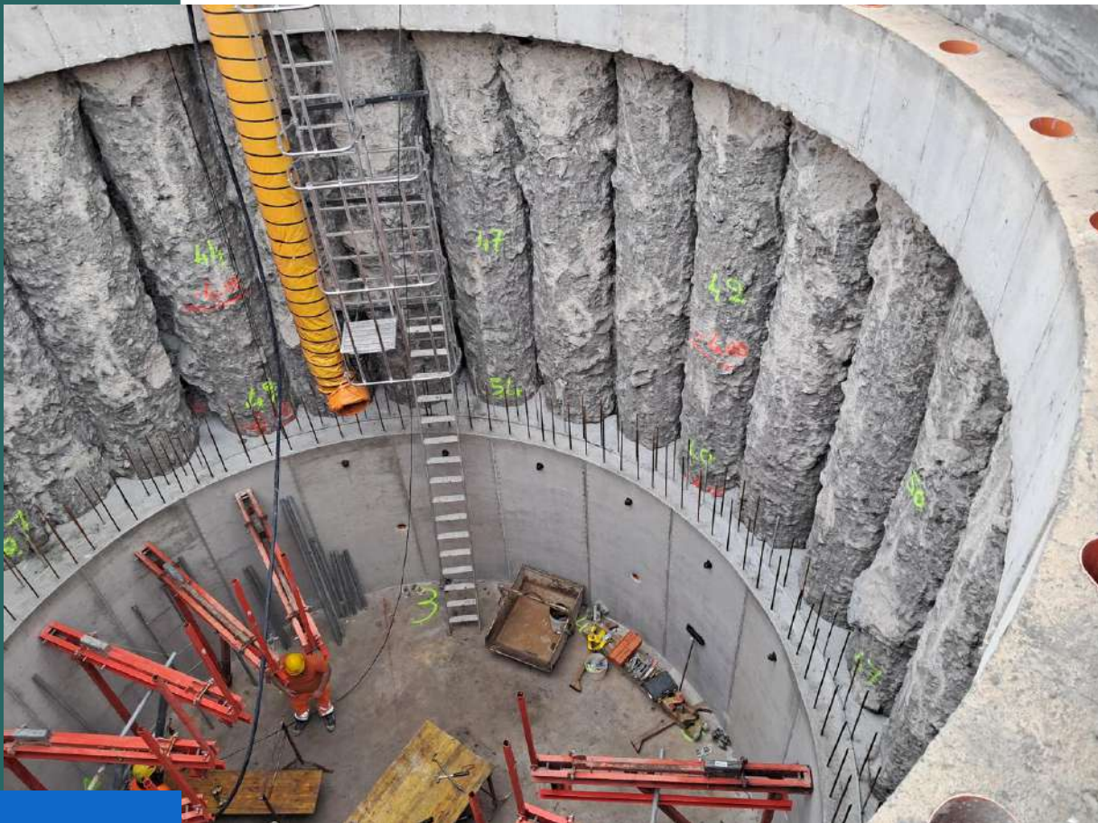
Foto in alto: avanzamento della realizzazione della centinatura Foto a fianco: getto del cls
