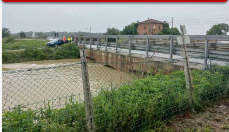
PONTE FOSSO VECCHIO SS 16 KM 136+800 (RAVENNA)
