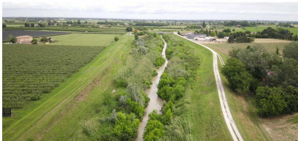
FIUME MONTONE – TRATTO A MONTE DEL CER (FC) - Maggio 2026
