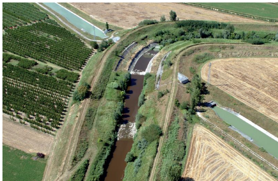
FIUME LAMONE (RA) - Attraversamento CER - 2019
