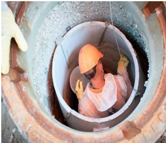
Riparazione dei pozzetti fognari
