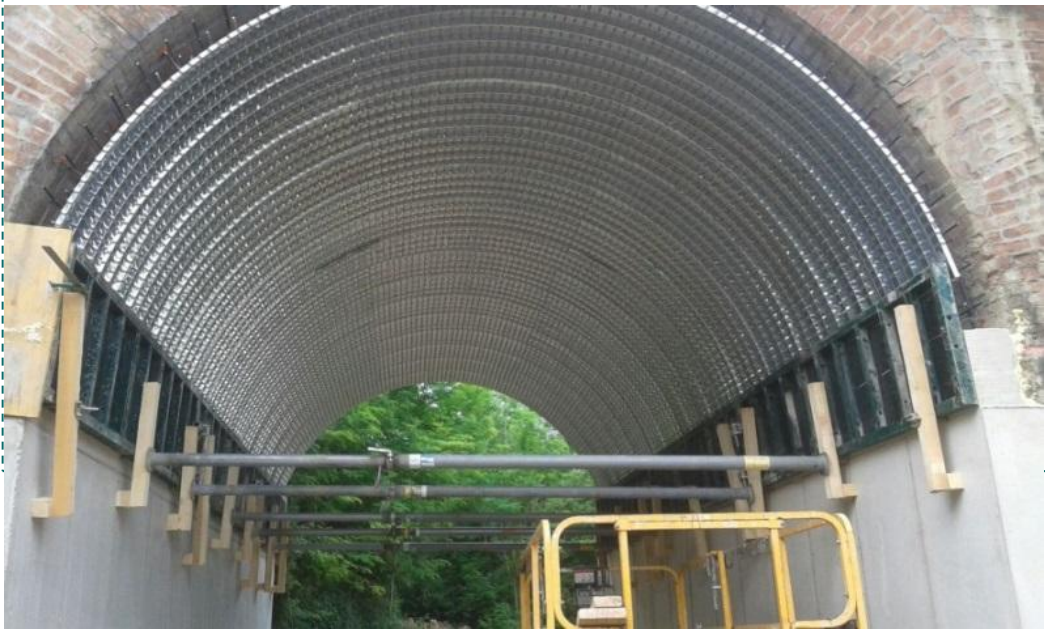
Fodera in c.a. su spalle pile e arco
